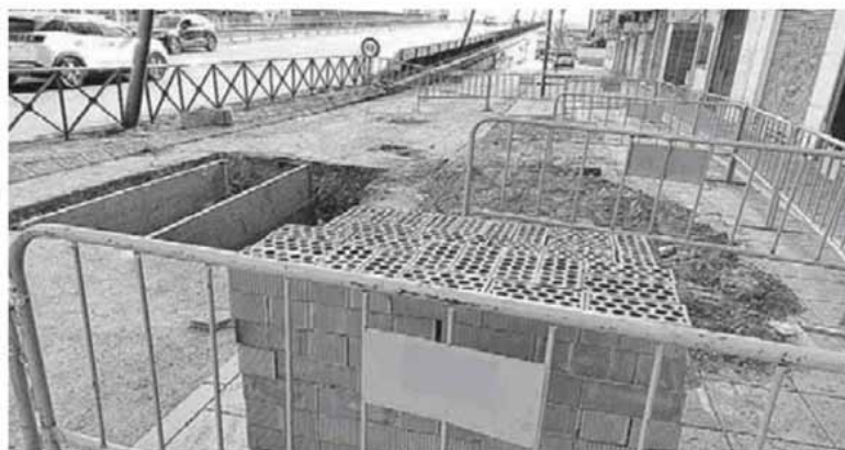
Tramo de las obras del AVE en Almería. LA VOZ
